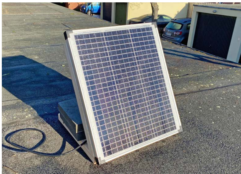
Das flache Garagendach eignet sich gut, um mal eben ein Solarpanel aufzustellen. Damit das Dach regenfest bleibt, haben wir nicht hineingeböhrt, sondern die Modulhalterung mit zwei Gehwegplatten beschwert – also mit etwas über 30 Kilogramm.
