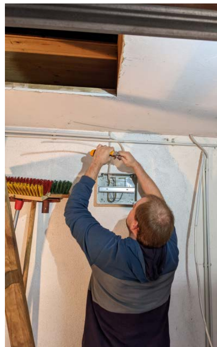
Elektrotechnische Laien dürfen durchaus Sicherungskästen setzen und Kabel vorbereiten. Nur den Anschluss ans Stromnetz muss man einem Profi überlassen.
