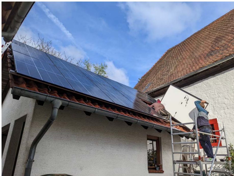
Pina Merkert verbindet hier das kurze Verlängerungskabel für den Gleichstromanschluss, während Jan Mahn das letzte Modul bereithält.
