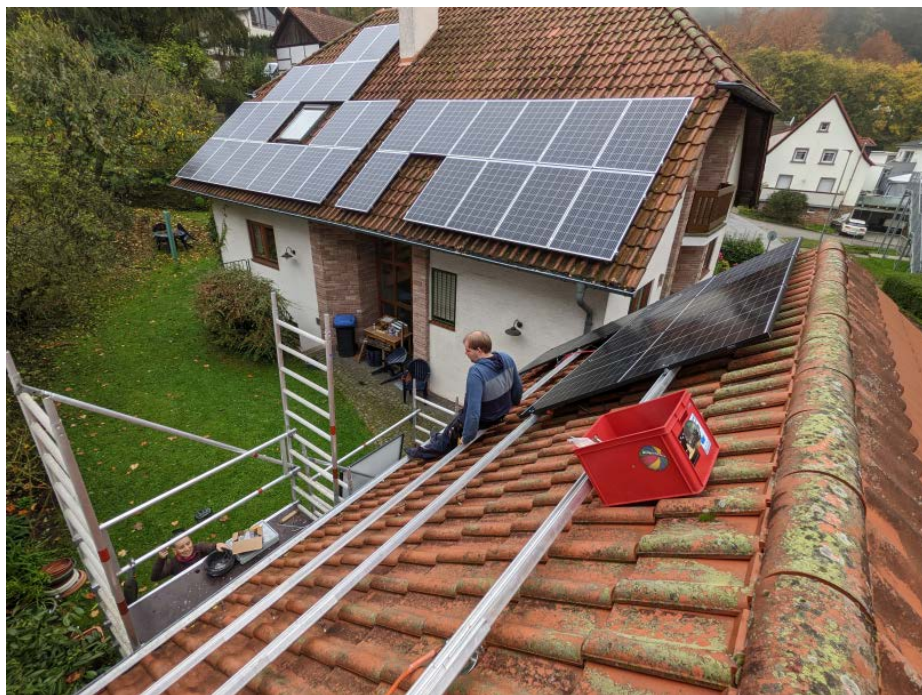
Am dritten Tag lag schon die Hälfte der Module auf dem Dach. Insgesamt arbeiteten wir zu dritt vier Tage lang an der Solaranlage.
