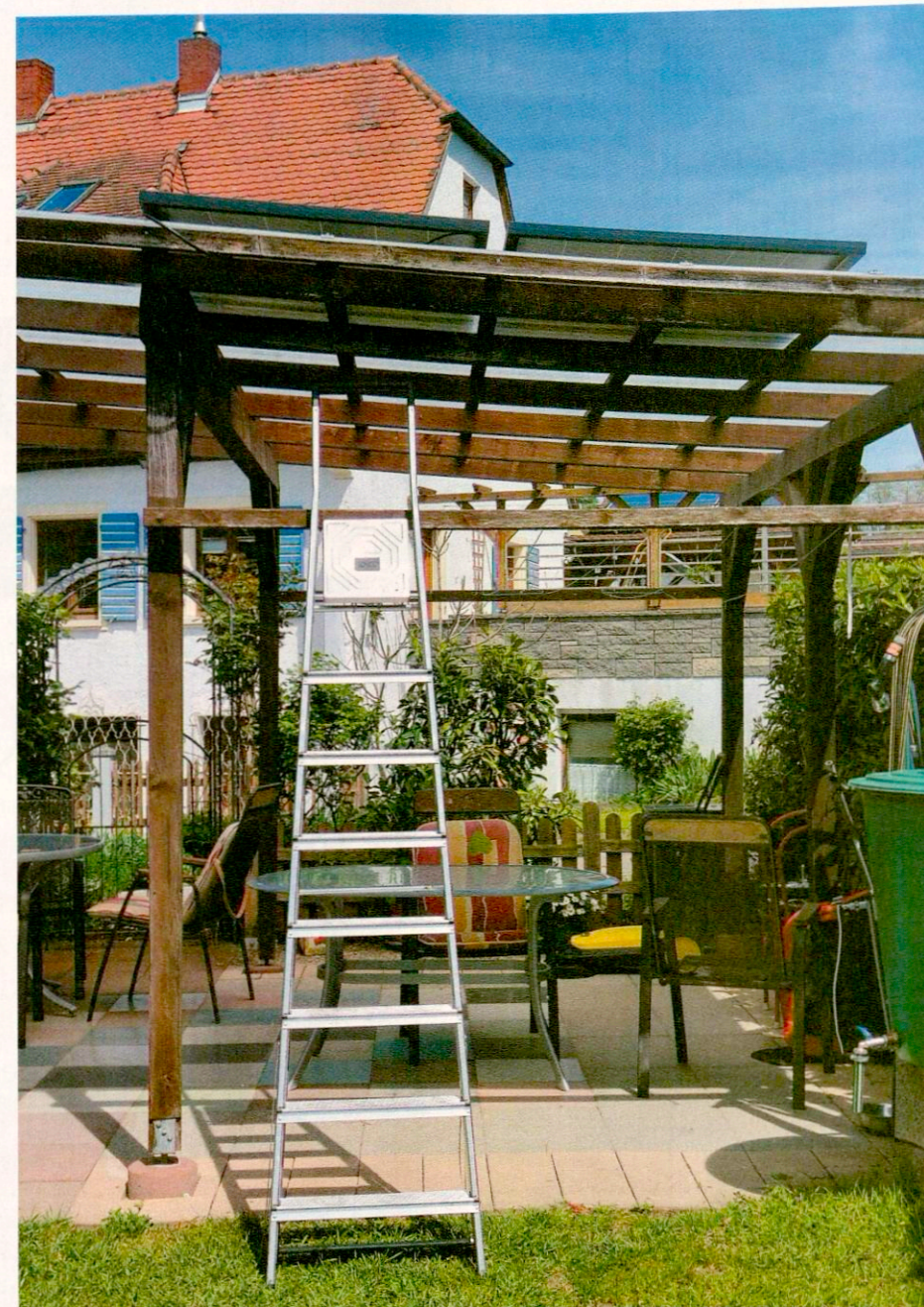
Bild 10. Geschafft: Die beiden Solarpanels samt Wechselrichter sind fest auf dem Vordach montiert.
