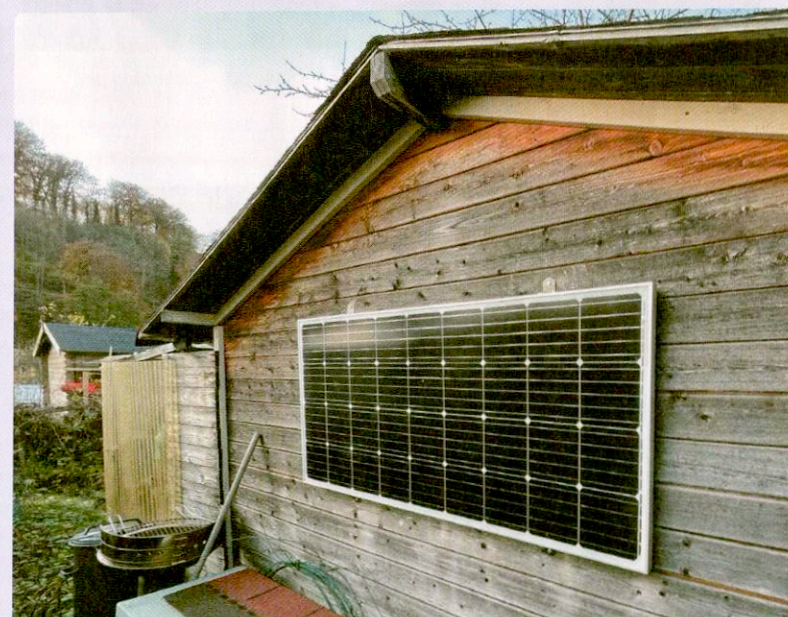
Bild 2. Das 12-V-Solarpanel am Gartenhäuschen von Klaus ist senkrecht montiert und liefert 180 Wp.
