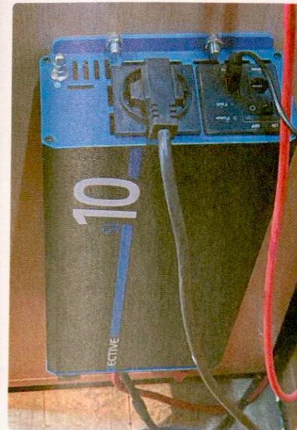
Bild 6. Der 1-kW-Inverter von Ective erwies sich bislang als sehr stabil und zuverlässig.
