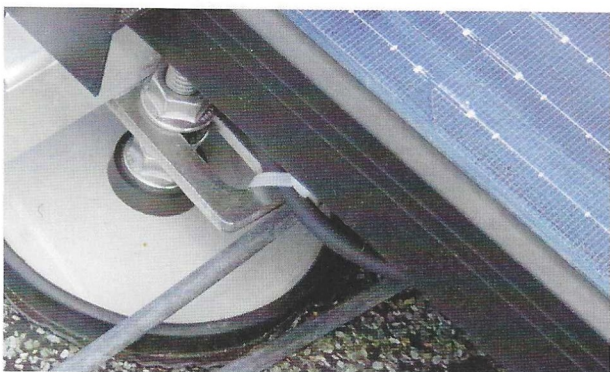
Bild 8: Für jede Einbausituation, hier auf einem Bitumendach, halten spezialisierte Anbieter passende Montagesets bereit, hier das BituPlan von Schletter.
